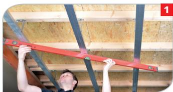
**1** Ebene, saubere, tragfähige Unterkonstruktion vorbereiten.
