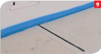
**9** Für ideale Messwerte Metall-Endkappe bündig mit der Oberseite abschließen lassen.
