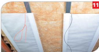
**11** Den elektrisch aktiven Heizbereich (410 mm) stets mit einem Abstand von je 10 mm zu jeder Seite zwischen den Trockenbauprofilen ausrichten.
