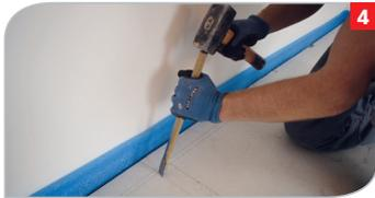
**4** Aussparungen für die Zuleitungen und Kontaktierungen der Heizvliese einbringen.
