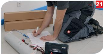
**21** Widerstand nach dem Anschluss der Kabel erneut überprüfen und Werte im Prüfprotokoll sowie in der Montage-Skizze dokumentieren.
