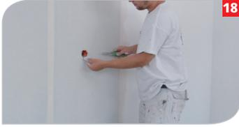
**18** Einbauten können bis zu einem  $\varnothing$  70 mm nachträglich eingebracht werden.
