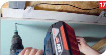
**17** Trockenbauplatte (max. Stärke 12,5 mm) gemäß Herstellerangaben montieren.
