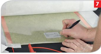
**7** Widerstände zugeschnittener Heizvliese erneut messen und auf Etikett, im Prüfprotokoll und der Montage-Skizze dokumentieren – Sollwerte den Widerstandstabellen entnehmen.
