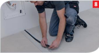
**8** Fühler-Anschluss-Set in der Aussparung verlegen. Den externen Temperaturfühler bis zur Endkappe (Messpunkt) führen.
