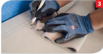
**3** Kabelführungen sowie Aussparungen für die Heizvlieskontakte anzeichnen.
