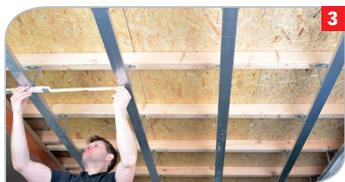
**3** Position der Heizvliese anzeichnen und den Standort des Netzteils bestimmen. Montage-Skizze erstellen.
