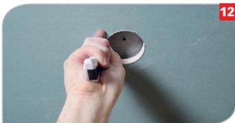
**12** Einbauten können bis zu einem  $\varnothing$  70 mm nachträglich eingebracht werden.
