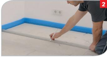
**2** Position der Heizvliese anzeichnen und den Standort des Netzteils bestimmen. Die Kabelführung sowie die maximale Entfernung zwischen Heizvlies und Netzteil beachten. Montage-Skizze erstellen.
