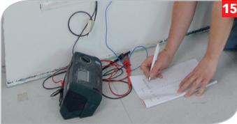
**15** Widerstand nach dem Anschluss der Kabel erneut überprüfen und Werte im Prüfprotokoll sowie in der Montage-Skizze dokumentieren.
