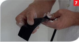
**7** Die metallische Endkappe des Fühler-Anschluss-Sets mit Isolierklebeband abkleben um Fehlerströme zu vermeiden.
