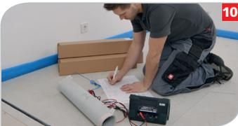
**10** Widerstand gemäß Montageanleitung & Bedienungsanleitung überprüfen und Werte im Prüfprotokoll sowie in der Montage-Skizze dokumentieren.
