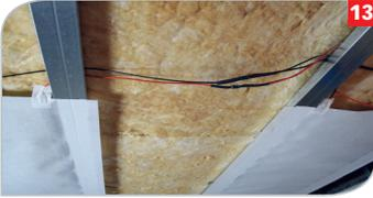
**13** Anschlusskabel verlängern und zum Netzteil führen.
