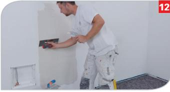
**12** Klebemörtel zum Verkleben der Heizvliese gemäß Herstellerangaben auftragen.
