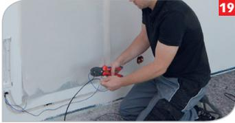
**19** Anschlusskabel verlängern und zum Netzteil führen.
