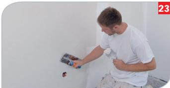
**23** Belag- und Deckschicht gemäß Herstellerangaben aufbringen.
