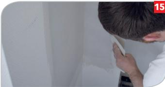
**15** Das Heizvlies kann über Eck montiert werden. Heizvlies mit Kunststoffspachtel ohne scharfen Knick einbringen.
